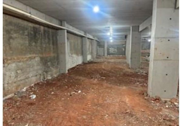
Julho/2024 – Terraplenagem (2º SS)
