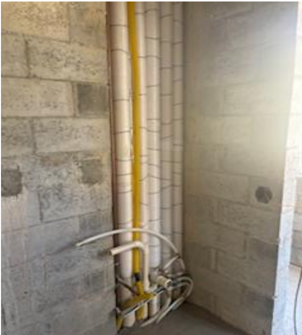
Julho/2024 - Vista Prumadas Hidr. (Apto Tipo)
