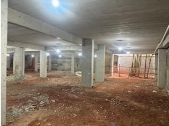
Julho/2024 -Terraplenagem (2º SS)
