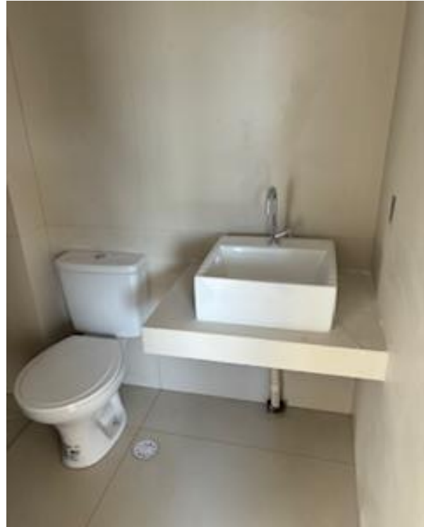
Julho/2024 – Vista Interna Banheiro (Apto. Tipo Personalizado)
