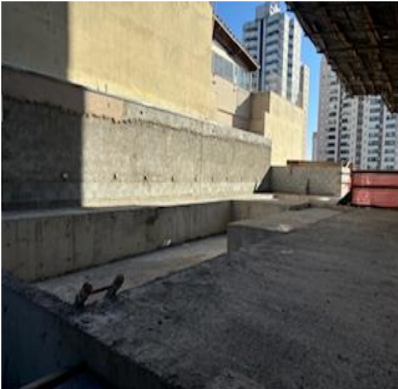
Julho/2024 - Vista Piscina (1º Pavimento)
