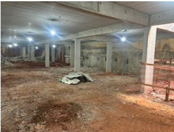
Julho/2024 – Terraplenagem (2ºSS)
