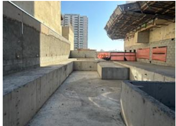
Julho/2024 - Vista Piscina (1º Pavimento)
