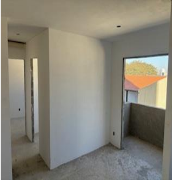
Julho/2024 - Vista Interna do (Apto. Tipo)
