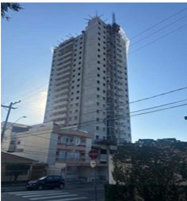
Julho/2024 – Vista Fachada (Montagem Balancins)
