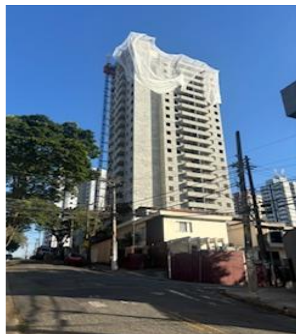
Julho/2024 – Vista Fachada (Instalação da Tela de Fachada)
