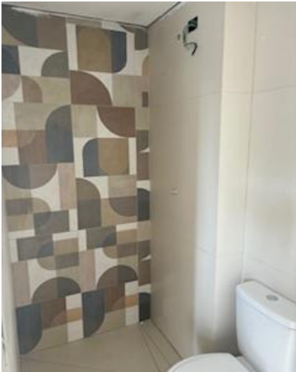
Julho/2024 – Vista Interna Banheiro (Apto. Tipo Personalizado)
