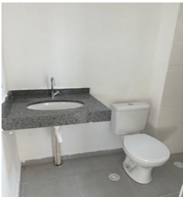
Julho/2024 - Vista Interna Banheiro (Apto. Tipo Padrão)
