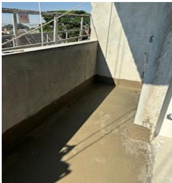
Julho/2024 - Vista Imperm. Varanda (Apto. Tipo Padrão)
